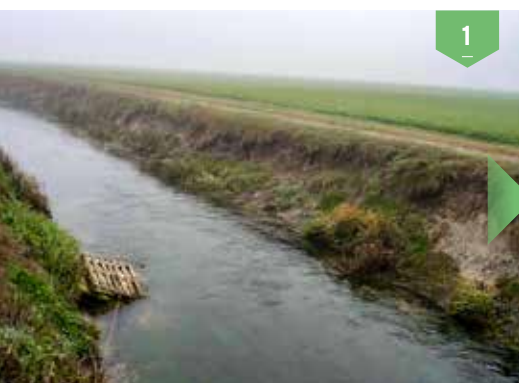
Situazione del canale prima dell'intervento
