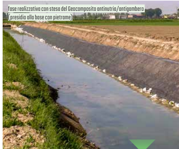
Fase realizzativa con stesa del Geocomposito antinutria/antigambero (presidia alla base con pietrame)
