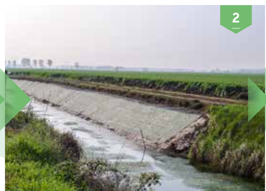
Fase realizzativa con stesa della rete metallica
