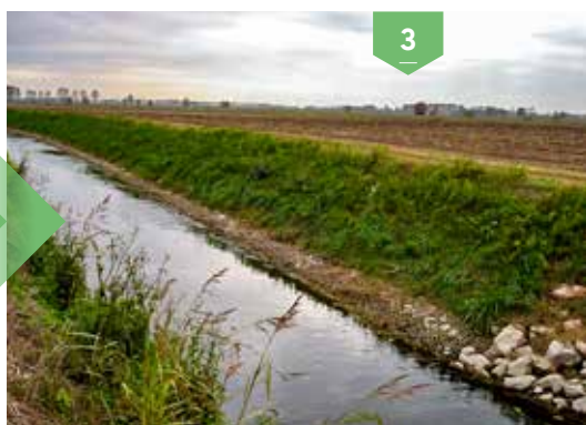
Fine lavori: rinverdimento e presidio alla base con gabbioni cilindrici
