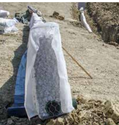
Posa del Pannello drenante Gabbiodren T nella bonifica di un versante per la realizzazione di un campo fotovoltaico
