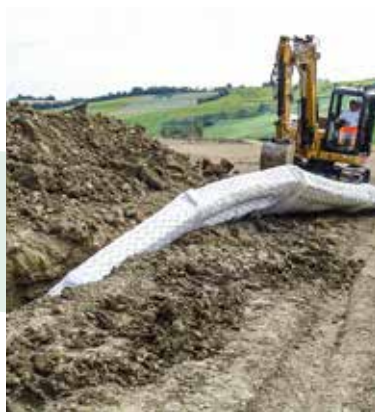
Posa del Pannello drenante Gabbiodren T nella bonifica di un versante per la realizzazione di un campo fotovoltaico
