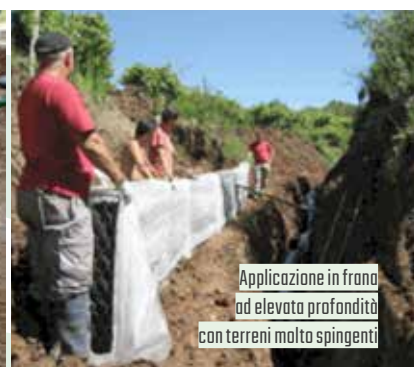
Applicazione dei Pannelli drenanti Gabbiodren FORTE nel drenaggio di percolati particolarmente aggressivi al piede di una discarica di accumulo di fanghi inquinanti
