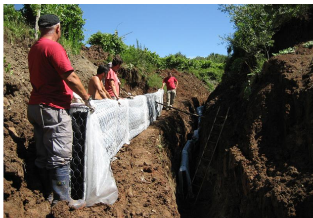
▲ Fasi di posa della trincea drenante GABBIODREN®
