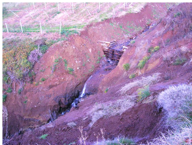
▲ Vista della briglia in legname e della trincea drenante
