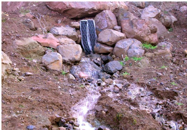
▲ Particolare della venuta a giorno della trincea drenante
