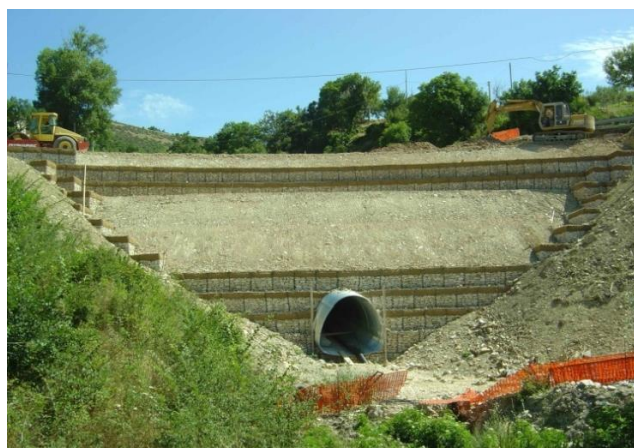
▲ Fasi di ultimazione dei lavori (rilevato lato di valle)
