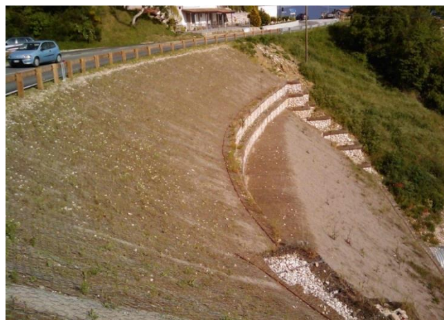
▲ Particolare del geocomposito R.E.C.S.® sulla scarpata del rilevato
