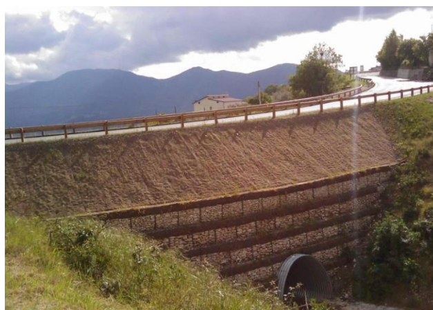
▲ Strada a lavori ultimati (lato di monte)
