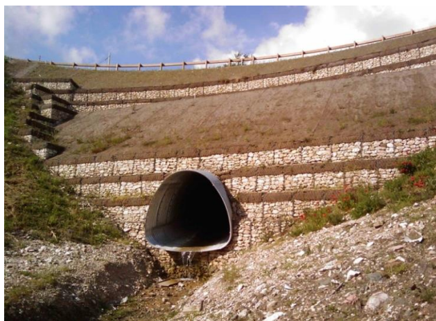
▲ Situazione a fine lavori (lato di valle)
