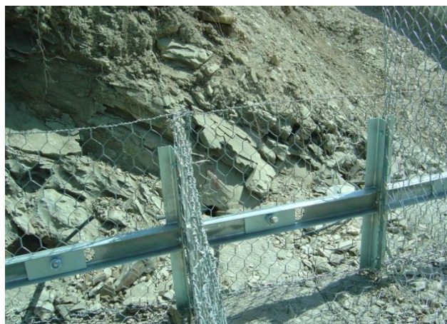
▲ Fasi di assemblaggio del gabbione chiodato
