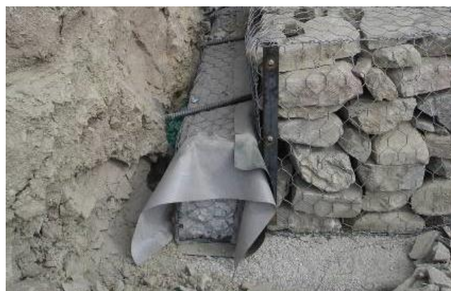
▲ Dettaglio del drenaggio GABBIODREN®
