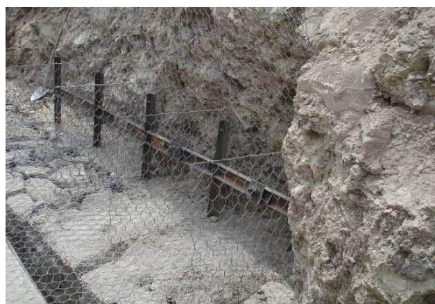
▲ Fasi realizzative del secondo ordine di gabbioni e chiodature
