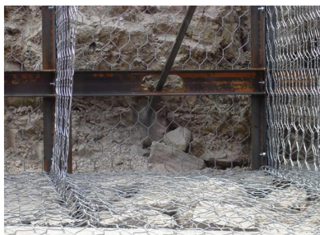
▲ Chiodature con barre autopercoranti cave \phi=32e/20i
