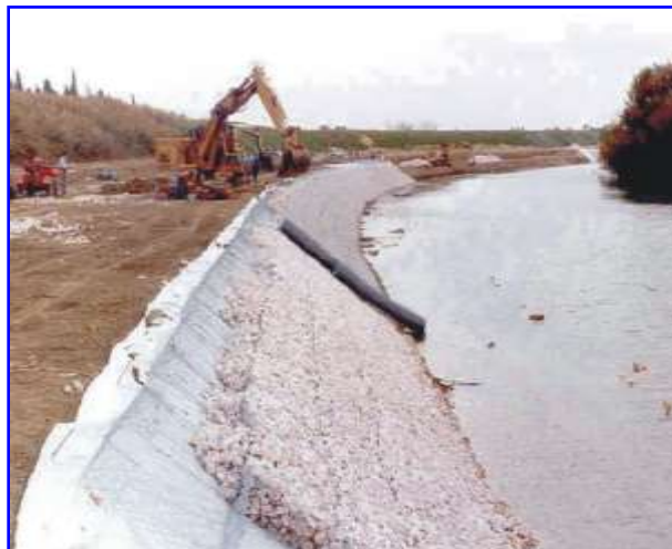
Foto 1 – Fasi di posa di un rivestimento in Materassi Metallici. Si nota la disposizione delle gabbie, il riempimento con pietrame e la chiusura dell'elemento con rotoli di rete
