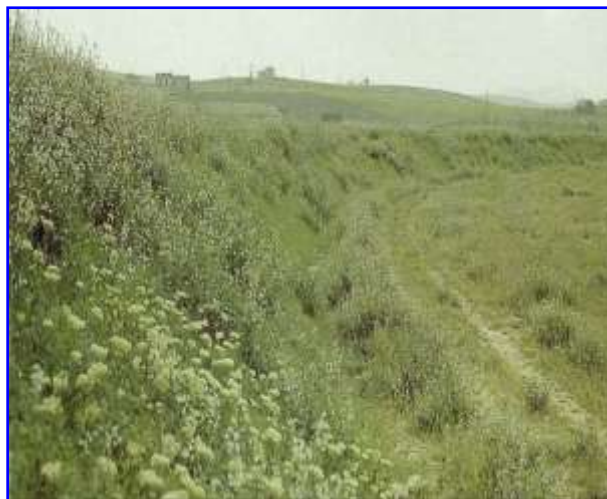
Foto 2 – Rivestimento di un argine golenale in materassi idraulici dopo il rinverdimento spontaneo
