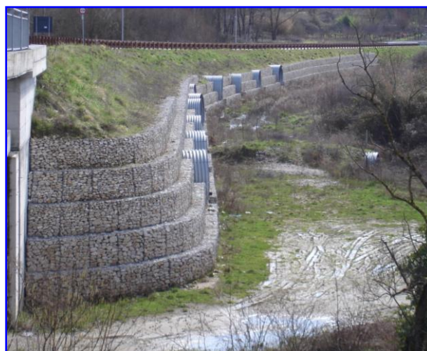
Foto 2 – Opera di contenimento e protezione idraulica di un rilevato di approccio ad un attraversamento sul Fiume Aniene.
