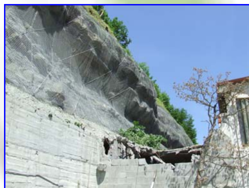
Foto 3 – R.E.C.S.™ MET. Applicazione in cantiere a Bolzaneto (GE). Il problema consisteva nella continua caduta di scaglie rocciose sulla strada e sul piazzale sottostanti. Scopo dell'intervento era inoltre il rafforzamento corticale dell'intero ammasso roccioso
