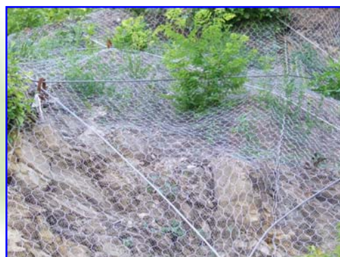
Foto 3 – R.E.C.S.™ MET. Applicazione in cantiere a Bolzaneto (GE). Il problema consisteva nella continua caduta di scaglie rocciose sulla strada e sul piazzale sottostanti. Scopo dell'intervento era inoltre il rafforzamento corticale dell'intero ammasso roccioso
