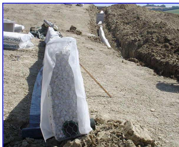
Foto 1 - Pannello drenante Gabbiodren®T nella bonifica di un versante per la realizzazione di un campo fotovoltaico
