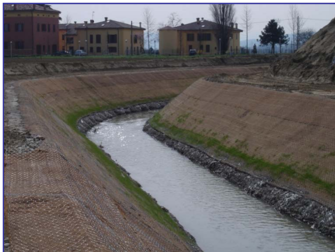
▲ Ultime fasi di rivestimento delle sponde
