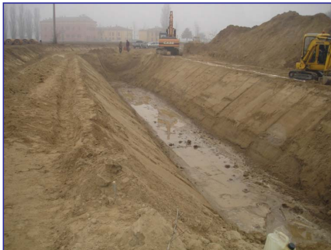
▲ Fasi di scavo e sagomatura del Canale
