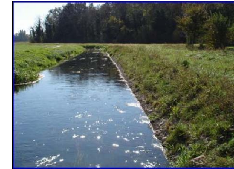
SITUAZIONE DELL'INTERVENTO A 5 MESI DA FINE LAVORI
