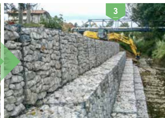
Gabbionata di difesa spondale su fondazione in gabbioni cilindrici - fine lavori
