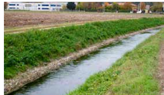
Presidio al piede con gabbioni cilindrici di stabilizzazione spondale in canale di bonifica
