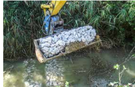
Posa di gabbione cilindrico in acqua mediante impiego di escavatore
