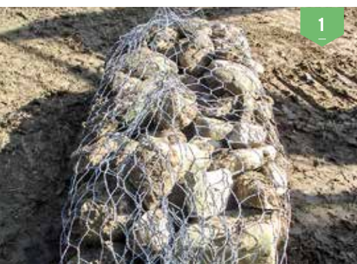
Gabbione cilindrico confezionato prima della relativa posa in opera
