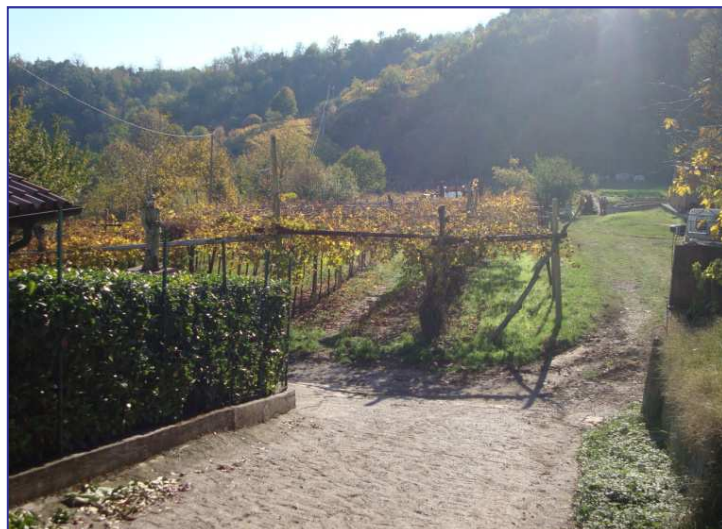
▲ AREA DI INTERVENTO IN DISSESTO
