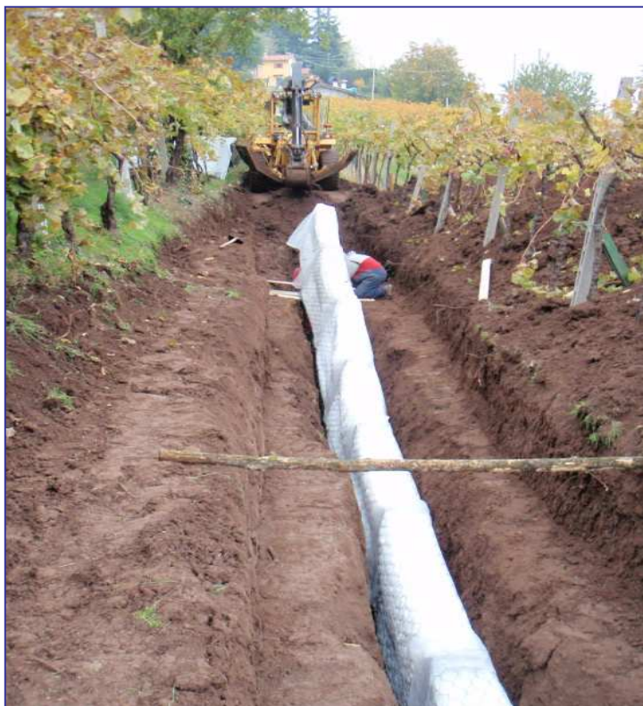
▲ MONTAGGIO E POSA DELLA LINEA DRENANTE TRA I FILARI DEL VIGNETO
