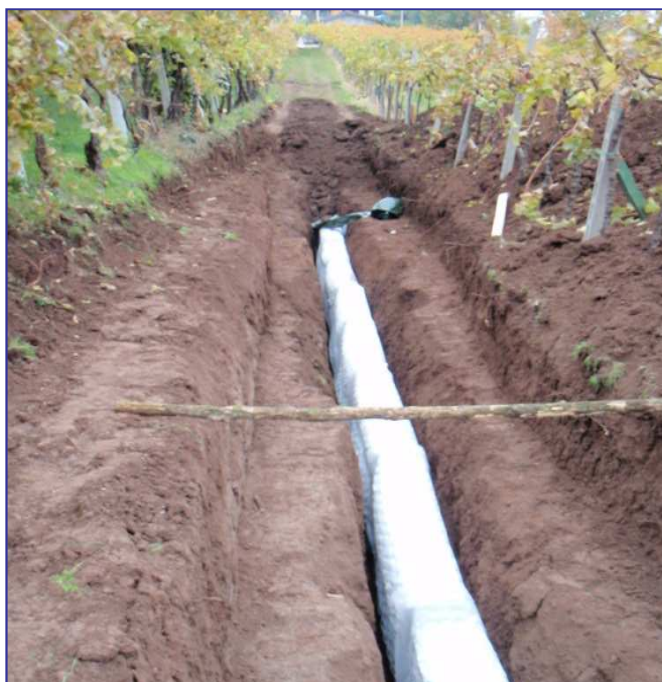
▲ POSA DEI DRENI TRA I FILARI DEL VIGNETO
