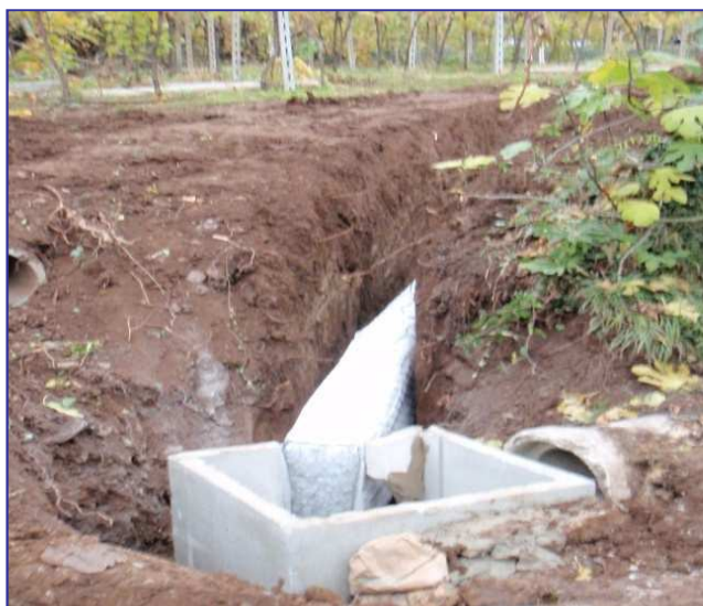
▲ FASI DI POSA IN OPERA DEL POZZETTO E INNESTO DEL PANNELLO
