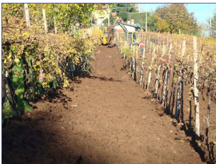
▲ SISTEMAZIONE DELL'AREA DI INTERVENTO A FINE LAVORI
