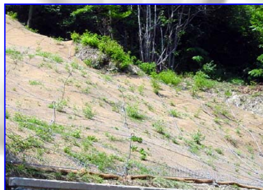
Foto 4 – Lavoro ultimato e prime fasi di rinverdimento
