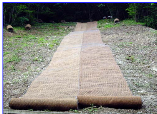
Foto 1 – Fasi iniziali di stesa e posa in opera
