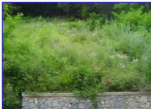
Foto 5 – Intervento dopo due mesi dalla fine dei lavori
