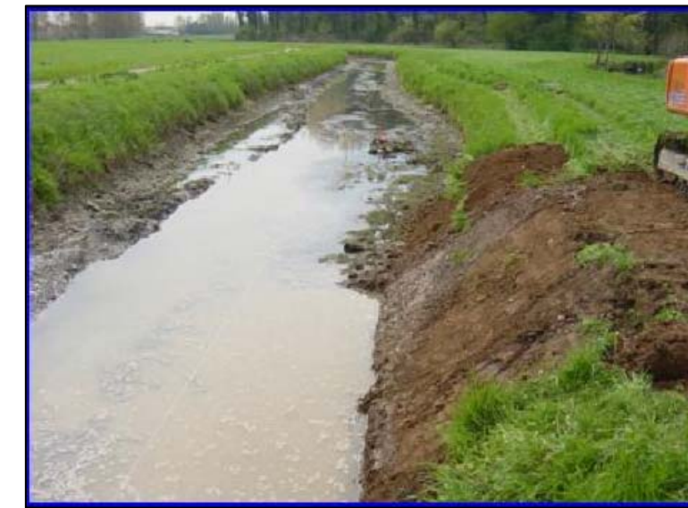
PULIZIA E REGOLARIZZAZIONE DELLA SPONDA
