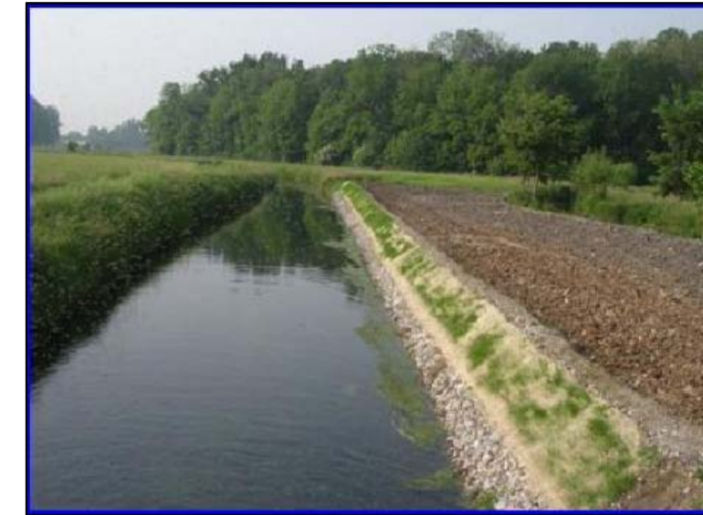
SITUAZIONE DELL'INTERVENTO A FINE LAVORI
