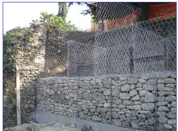
▲ Realizzazione del secondo ordine di gabbioni con sistema di chiodatura
