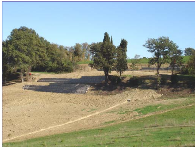
▲ Veduta dell'intervento a lavori ultimati
