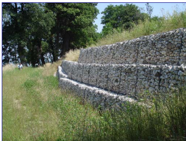
▲ Vista della gabbionata di monte alla strada vicinale
