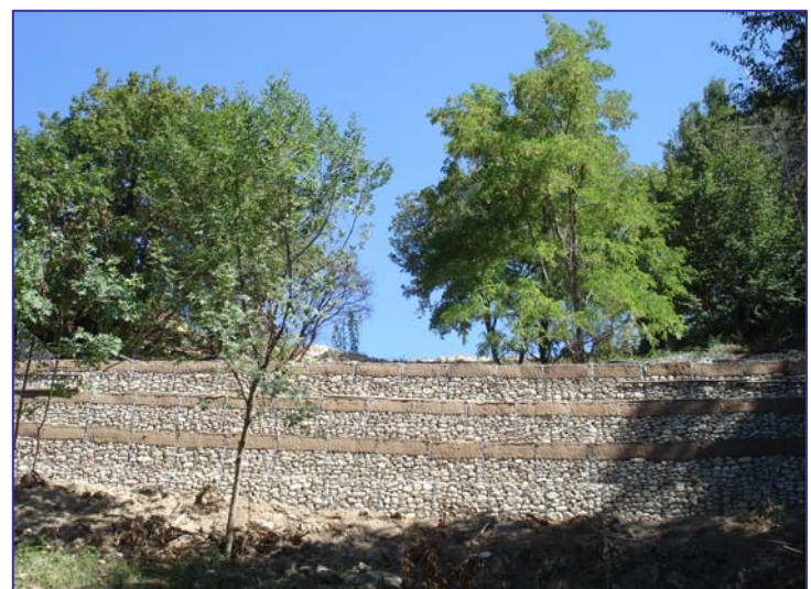
▲ Vista d'insieme dell'opera nelle ultime fasi costruttive
