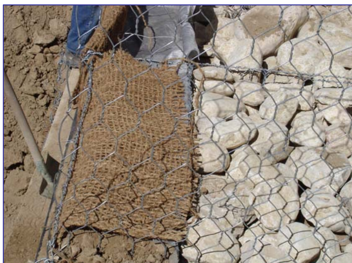
▲ Dettaglio della tasca vegetativa dopo il riempimento con terreno vegetale
