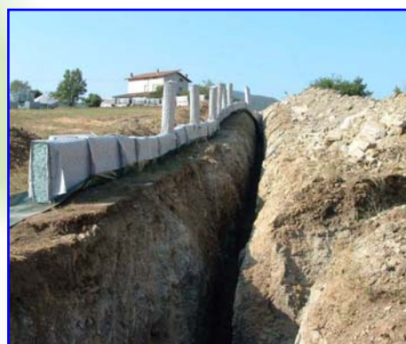
Foto 2 – Trincea pronta per essere calata
