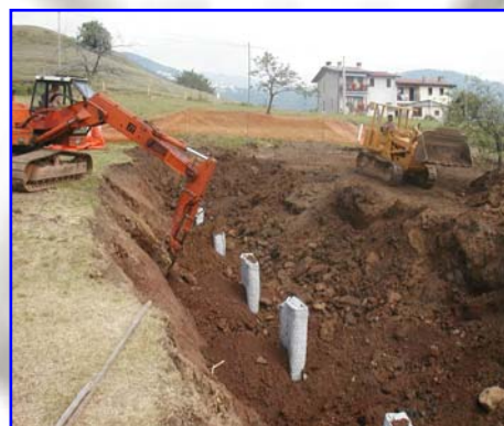
Foto 4 – Rinterro della trincea di scavo, si noti la presenza di camini drenanti
