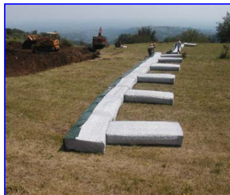
Foto 1 – Assemblaggio fuori scavo della linea drenante con pannelli Gabbiodren™ e guaina
