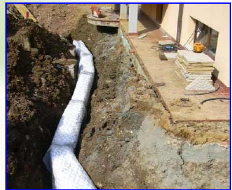
Foto 6 – Esempio di utilizzo in ambito edilizio con esigui spazi di lavoro ed esigenze di ridurre al minimo scavi e mobilitazione di materiali
