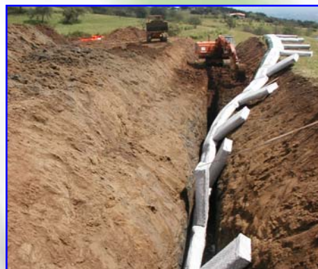
Foto 3 – Avanzamento dello scavo e contestuale posa della linea drenante
