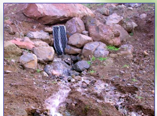
Foto 3 – Particolare della venuta a giorno della trincea drenante
