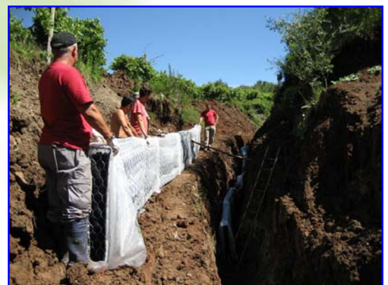
Foto 2 – Fasi di posa in opera della trincea Gabbiodren™ FORTE nei lavori di drenaggio e consolidamento idrogeologico presso la frana delle Lore, San Giovanni Ilarione (VR)
