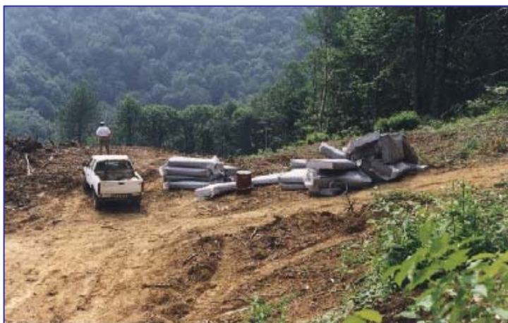
▲ Area di stoccaggio dei materiali raggiungibile solo con escavatore o mezzo 4x4
