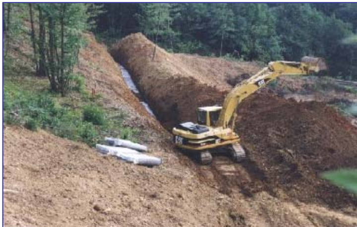
▲ Scavo e posa della trincea drenante prefabbricata Gabbiodren™
