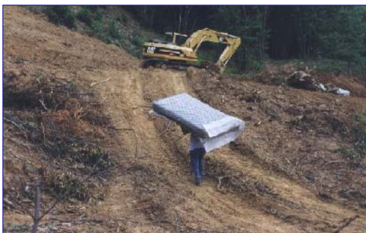
▲ Le particolari condizioni del cantiere impongono movimentazioni manuali dei pannelli Gabbiodren™ (peso < 20kg CAD)
