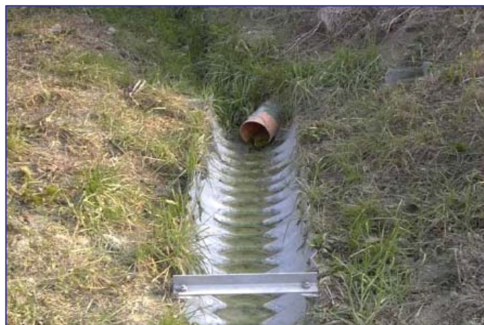
▲ Le acque di scarico delle trincee sono state convogliate alla rete fognaria mediante canalette semicircolari in lamiera zincata
