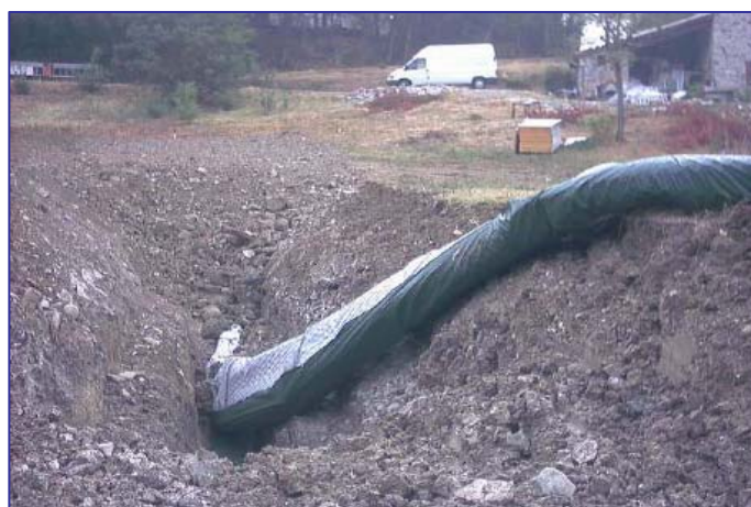
▲ Fasi di posa delle trincee Gabbiodren™ con guaina impermeabilizzante alla base
