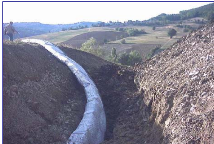
▲ Operazioni di posa in opera delle trincee drenanti
