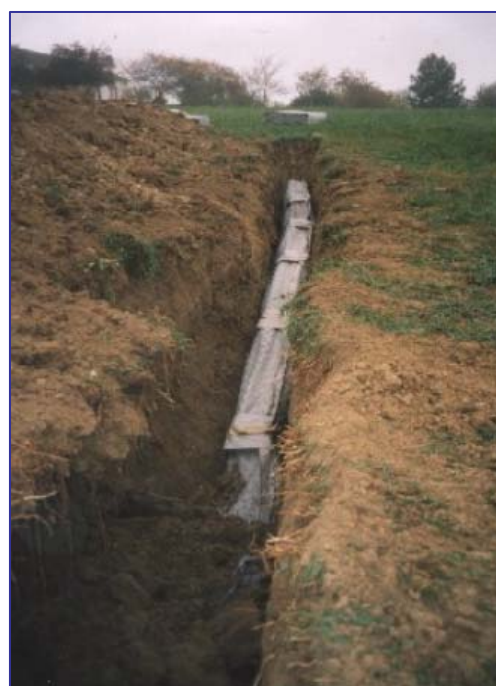
▲ Operazioni di reinterro della trincea drenante
