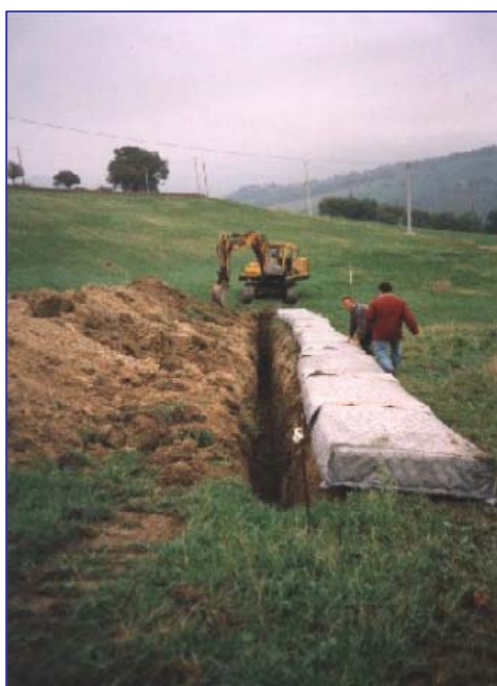
▲ La pannellata risulta leggera e maneggevole da posizionale in trincea
