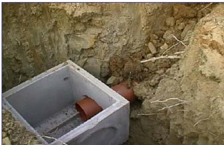
▲ Dettaglio del pozzetto di ispezione nella zona terminale della trincea drenante
