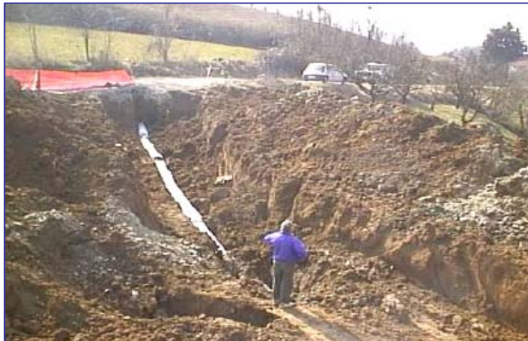
▲ Operazioni di ripristino del pendio e realizzazione delle trincee drenanti Gabbiodren™
