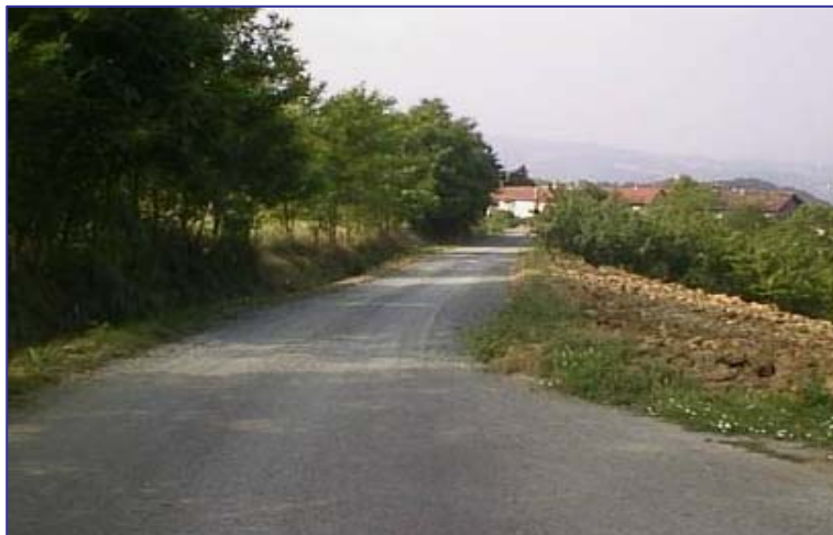
▲ Situazione a fine lavori
