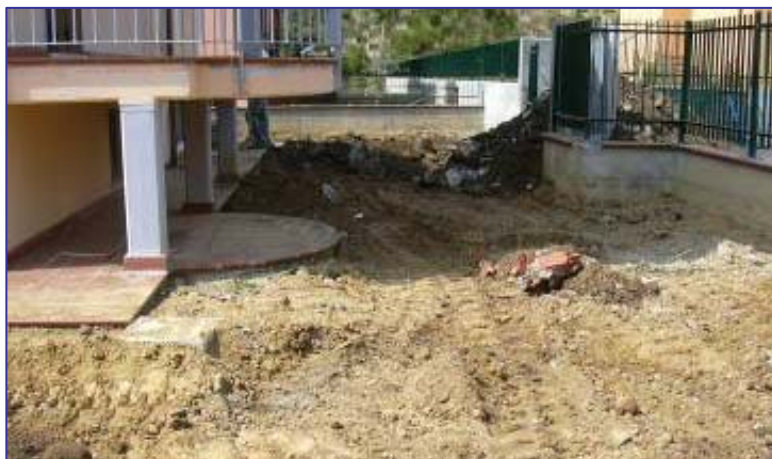
▲ Situazione a fine lavori
