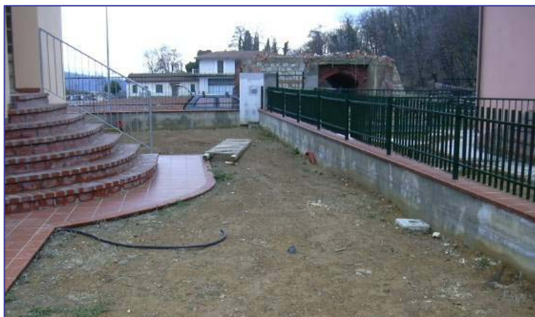
▲ Zona di realizzazione della trincea drenante
