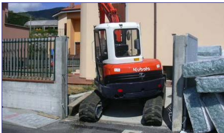
▲ Spazi di lavoro, logistica e sicurezza delle operazioni hanno suggerito il Gabbiodren™
