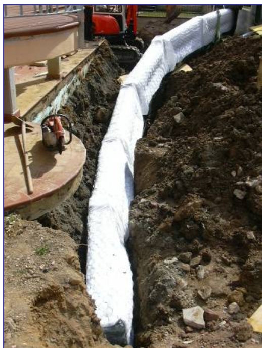
▲ Fasi realizzative della trincea drenante
